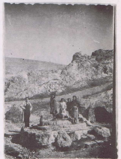
La Pozanca Agua potable
