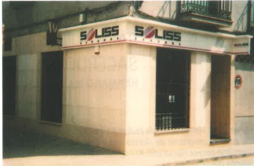
Fachada de las nuevas instalaciones, sitas en Cl. Mayor-Alta, 8 (antes BANCO CENTRAL)
