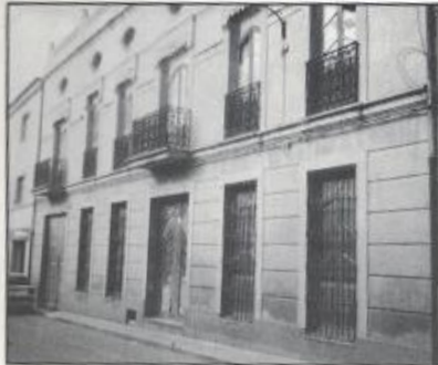
Casa de las Clementinas
