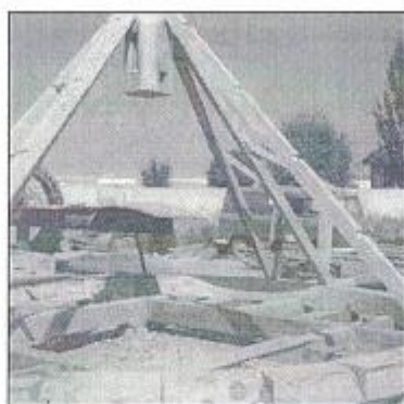
Molino en construcción para los Yébenes. Autor: José Moreno
